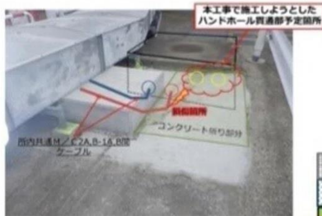
現場状況写真
